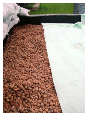
FIGURA 5 – Camada filtro sobre camada drenante Fonte: Acervo pessoal da autora
