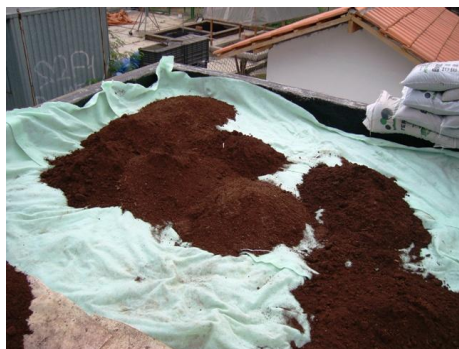
FIGURA 6 - Camada filtro e primeira camada de substrato Fonte: Acervo pessoal da autora
