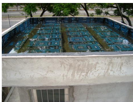
FIGURA 2 - Teste de estanqueidade da impermeabilização Fonte: Acervo pessoal da autora
