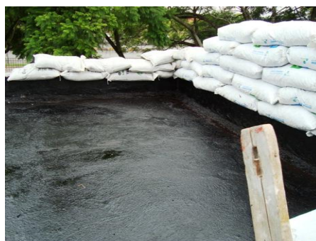
FIGURA 3 - Aplicação de herbicida sobre laje impermeabilizada Fonte: Acervo pessoal da autora
